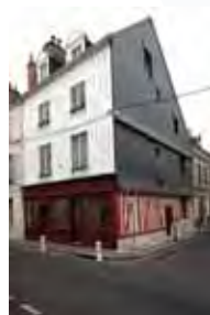
56 rue de Bourgogne, maison à boutique ou atelier, pan-de-bois de la deuxième moitié du 18 e siècle, restaurée dans son état du tout début du 19 e siècle, boutique en applique de la fin du 19 e siècle
