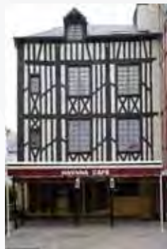
28 place du Châtelet, maison à boutique ou atelier, pan-de-bois de la deuxième moitié du 16 e siècle, restaurée dans son état du 18 e siècle
