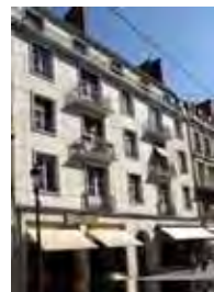
8 rue de la République, immeuble de rapport, bâtiment dit de la Reconstruction (après 1945)
