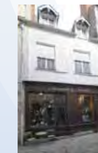
274 rue de Bourgogne, maison-double à boutique ou atelier, pan-de-bois de la deuxième moitié du 16 e siècle, restaurée dans son état du tout début du 19 e siècle (avant 1824)
