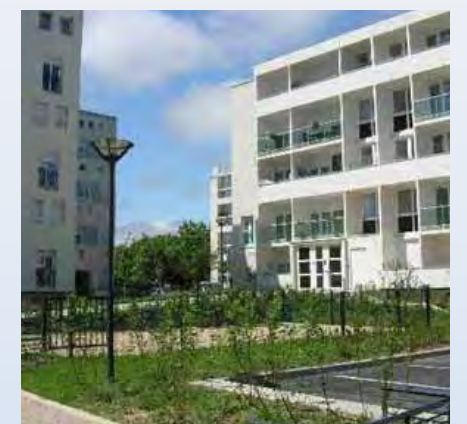
Réhabilitations et constructions de l'OPH Les Résidences de l'Orléanais
