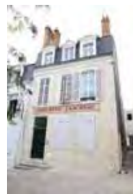
3 Cloître-Saint-Pierre-Empont, maison de ville, deuxième moitié du 18 e siècle, enseigne postérieure
