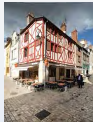
25 rue de la Poterne, maison-double à boutique ou atelier, pan-de-bois de la deuxième moitié du 14 e siècle (1394), restaurée dans son état du 18 e siècle
