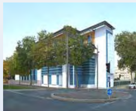
Pôle Emploi - Maison de l'emploi, un nouvel équipement livré en 2013 - SEMDO / SEM Patrimoniale - Cabinet Autret architecture
