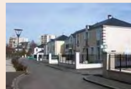
Maisons individuelles mitoyennes, quartier du Clos Rozay à Saint-Marceau
