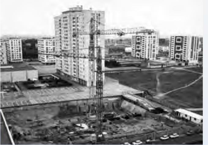
Chantier de construction de la mairie et du commissariat de La Source 1975-1980 - Archives Municipales
