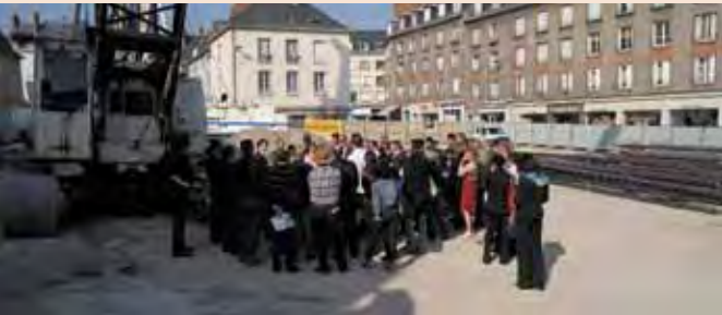
Visite de chantier de la place de Cheval Rouge, 30 mars 2012
