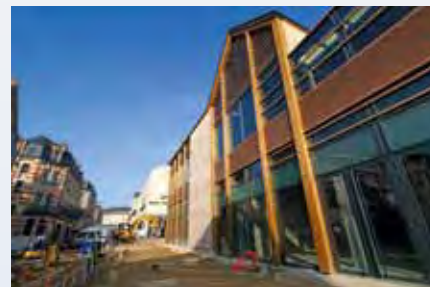
Chantier à l'été 2012
