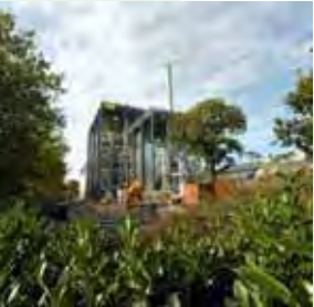
Chantier de la chaufferie biomasse de la Source
