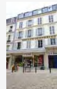
27 place du Châtelet, immeuble de rapport, deuxième moitié du 19 e siècle (après 1880)
