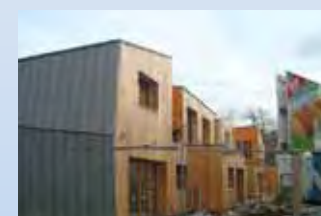
Chantier des cinq maisons passives Les Résidences de l'Orléanais - GA Architecture
