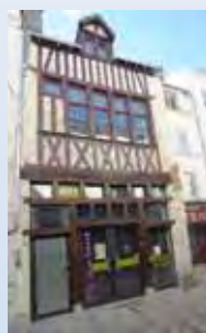
227 rue de Bourgogne, maison à boutique ou atelier, pan-de-bois de la deuxième moitié du 16 e siècle
