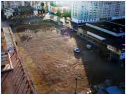
Chantier en cours
