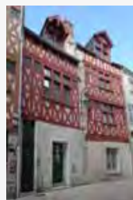
35 rue de l'Empereur, façade sud, maison à boutique ou atelier, pan-de-bois de la deuxième moitié du 16 e siècle (1569) ; façade nord, maison à boutique ou atelier, pan-de-bois de deuxième moitié du 15 e siècle (1483) ; pans-de-bois restaurés dans leur état de la deuxième moitié du 16 e siècle
