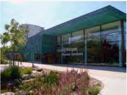
Médiathèque Maurice Genevoix (Ville d'Orléans / SEMDO - P. Seurin architecte)
