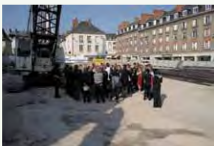
Centre-ville • 30 mars 2012 Visite du chantier de la place du Cheval-Rouge
