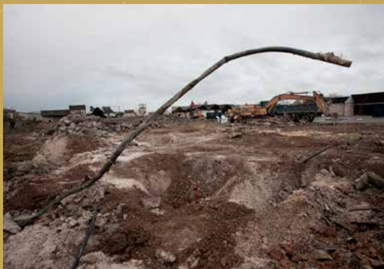
Friche Comasec pendant travaux, Dreux/Vernouillet
